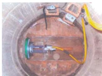
Burstfix verspannt die Rohrmodule sicher und kontrolliert.
